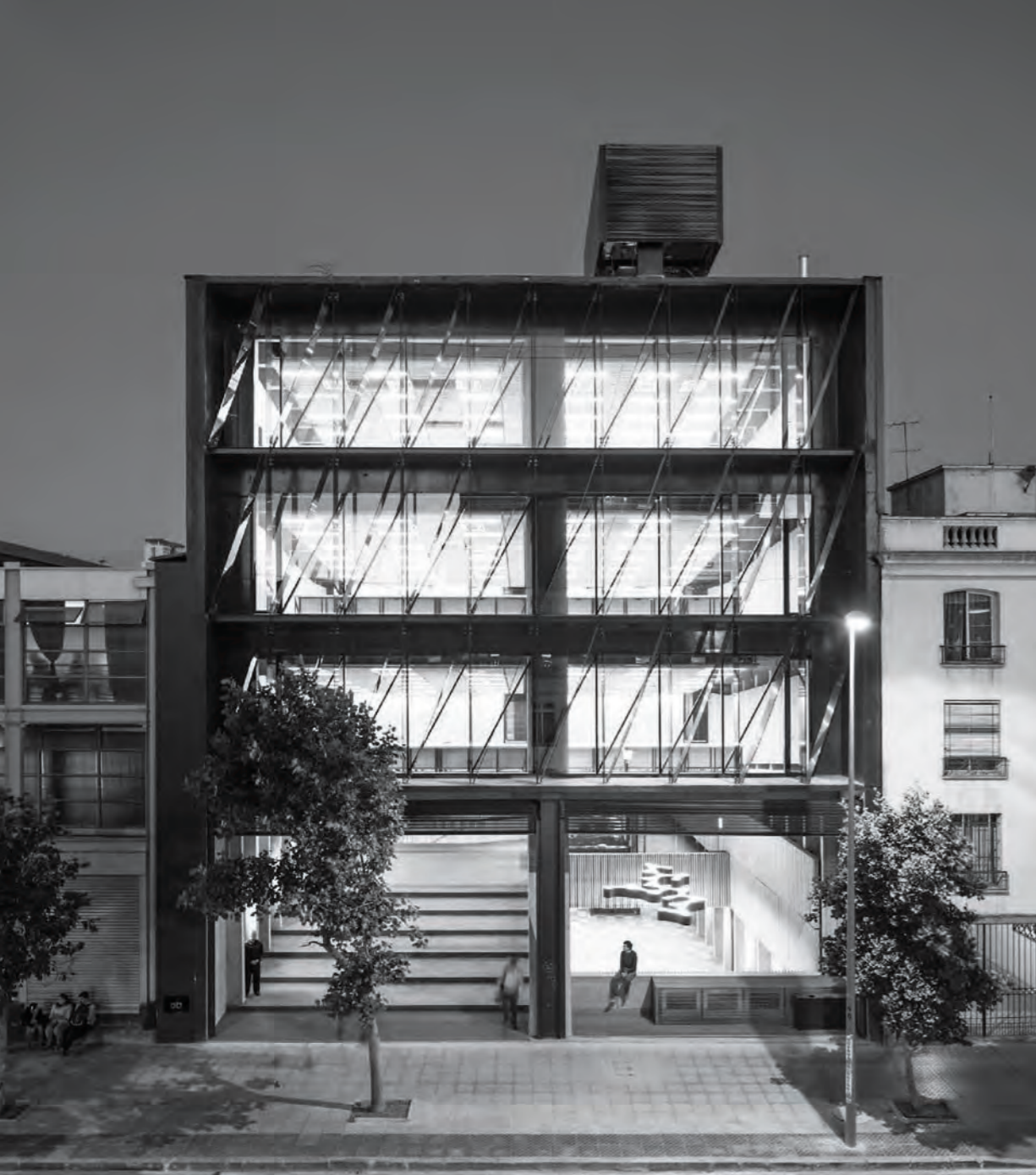
Edificio de Aulas
