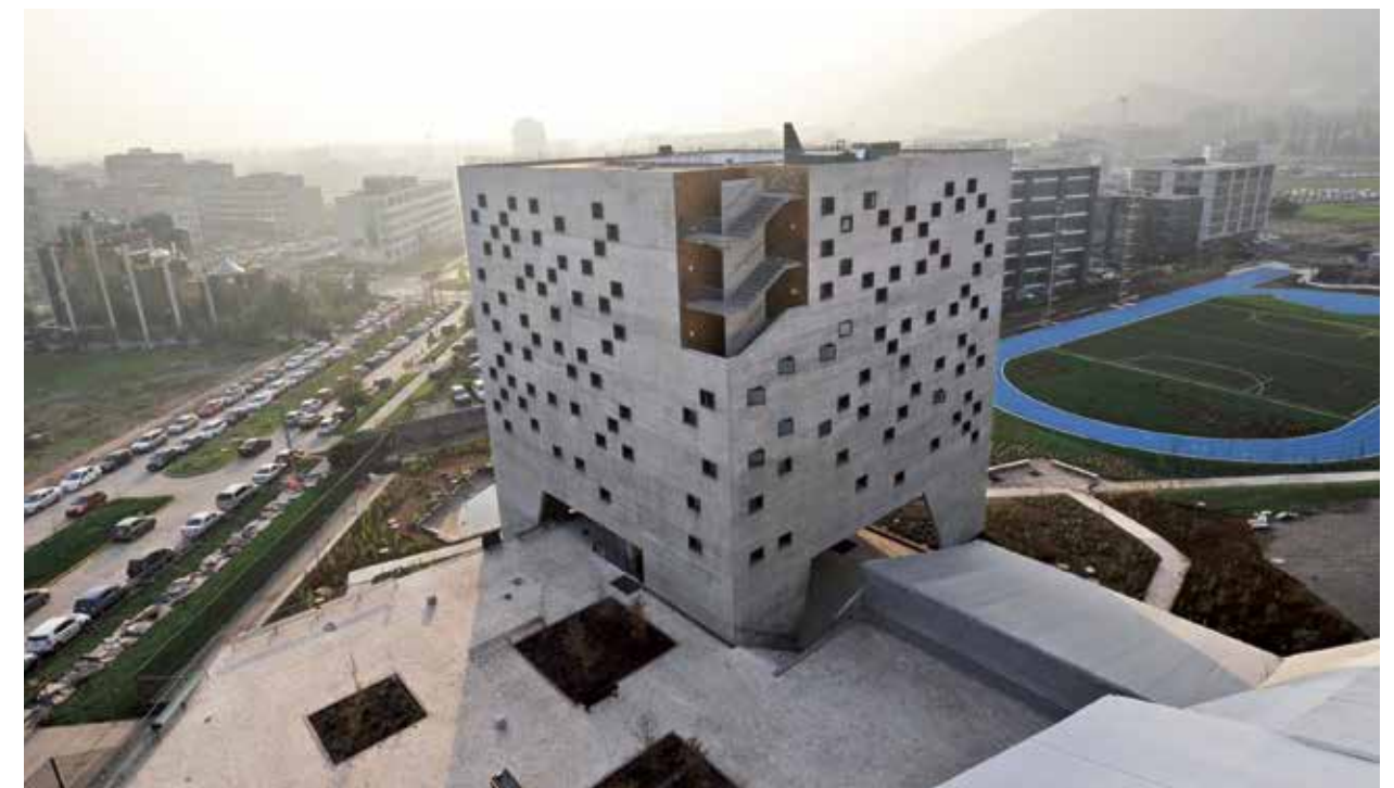
La Facultad de Economía y Empresa está en Ciudad Empresarial y cuenta con más de 16.000 m2 construidos.
